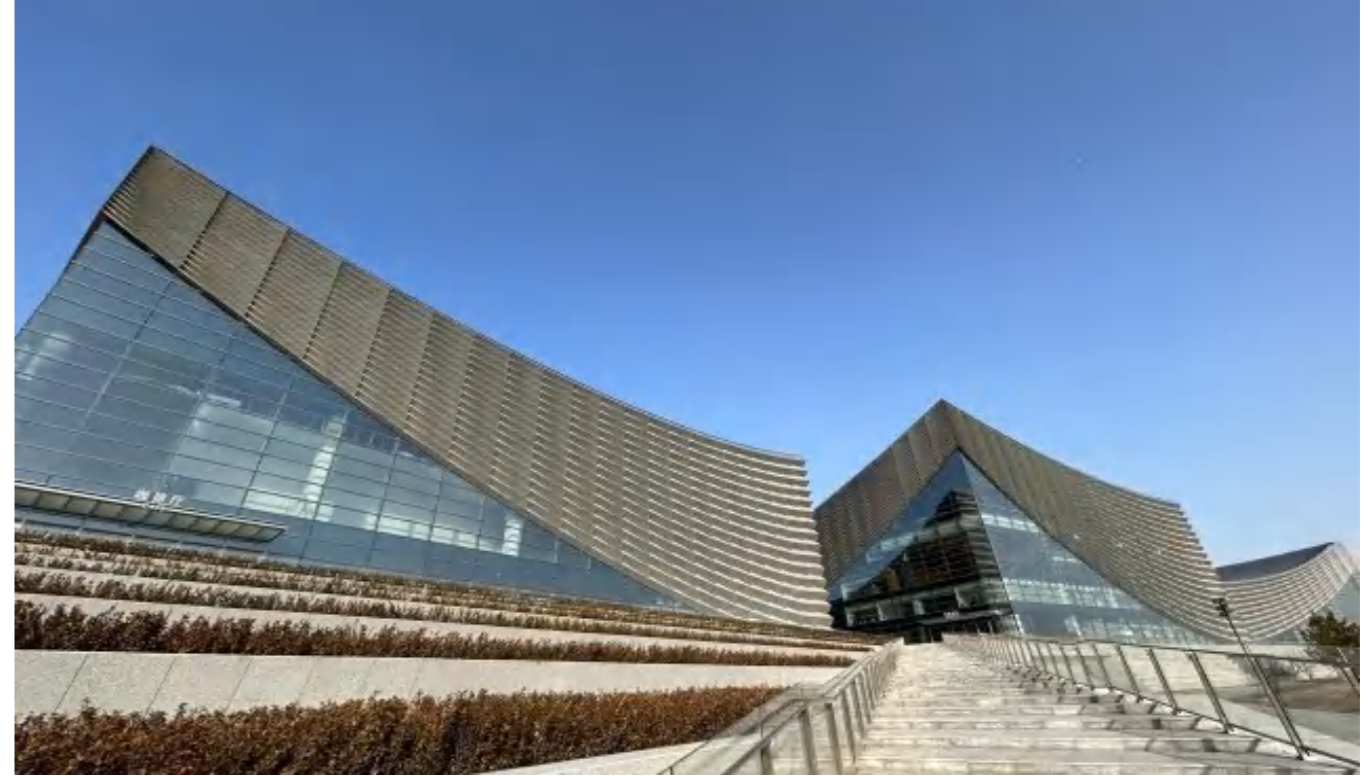
项目名称：城市副中心剧院建设工程 建筑面积：125350平方米
