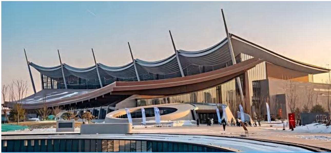
项目名称：首都博物馆东馆建设工程 建筑面积：99700平方米
